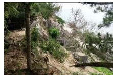
坍毀的構造設施 2
