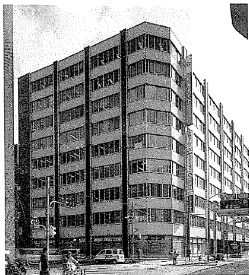
圖 5 改修前的辦公大樓 (建築リノベーション事例と実務)
