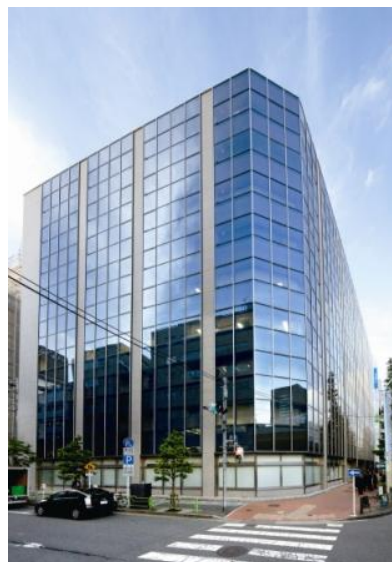
圖 6 改修過後的辦公大樓，收益也因此得以提升， (建築リノベーション事例と実務)
