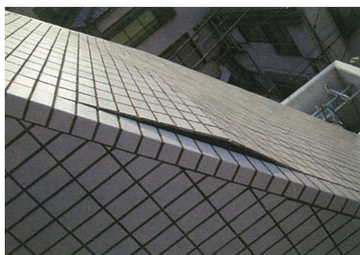
圖 2 膨脹後的外牆磁磚
