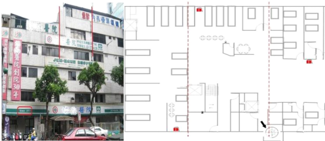
圖 2：左圖為 A2 醫院之連棟建築物三戶相互打通外觀情形；右圖為內部變成方便照護之開放空間，左右兩側直通樓梯已移除，中間下方增設樓層間之室內旋轉梯供內部行政或醫護人員使用。
