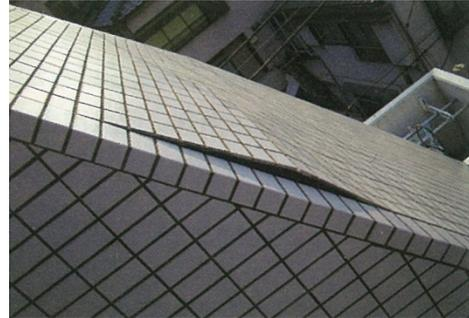
圖3 膨脹後的外牆磁磚
