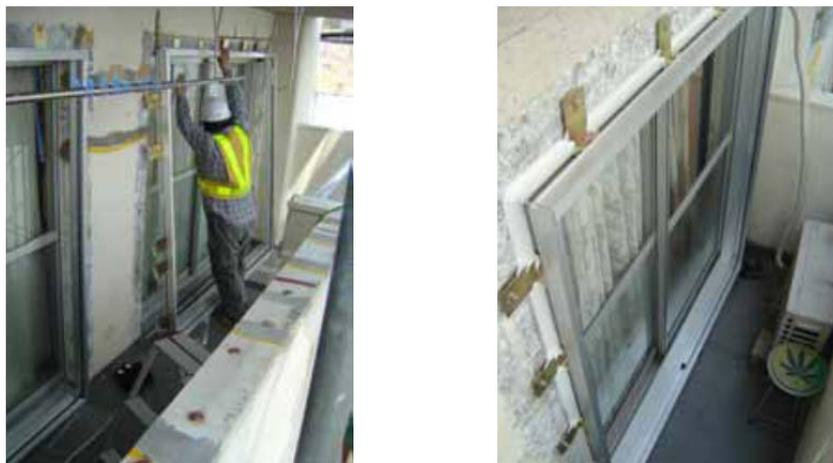
圖 17 新增開口部窗戶採用外覆式的工法同時也皆具隔熱的功能(國土交通省，2004)
