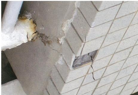
圖2 磁磚的龜裂及剝落
